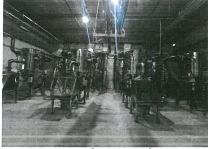
Şekil 5 Bitki Koruma Ürünleri Tesisi Toz Üretim Hattı
